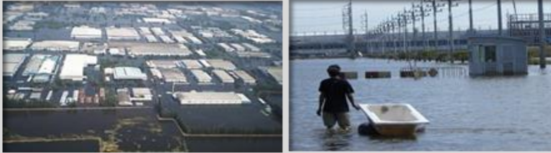
Flooding in Rojana Industrial Estate, Thailand (Oct-Nov 2011) タイ、ロジャナ工業団地の浸水 Source : MLIT
