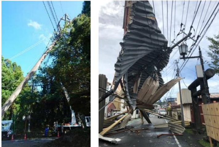
＜倒木・飛来物による電柱損壊現場の様子＞
